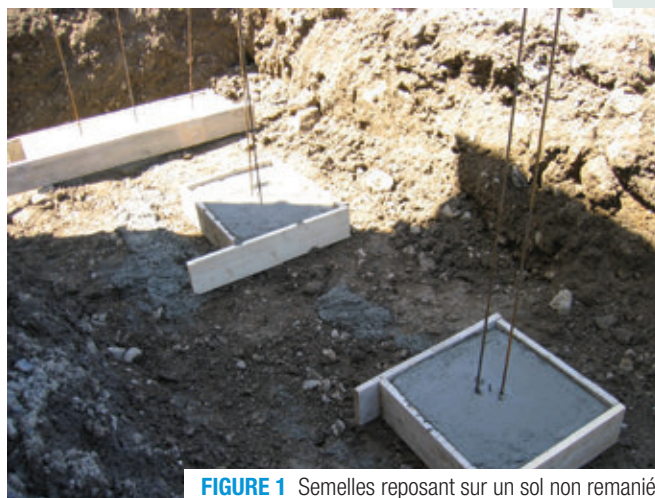
FIGURE 1 Semelles reposant sur un sol non remanié
