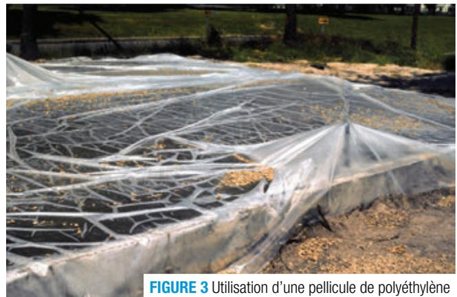
FIGURE 3 Utilisation d'une pellicule de polyéthylène
