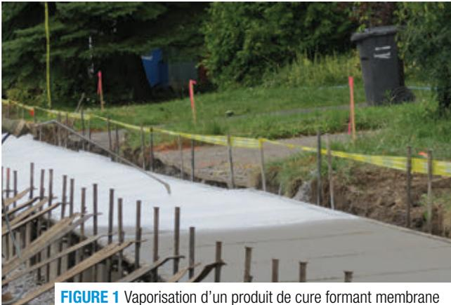
FIGURE 1 Vaporisation d'un produit de cure formant membrane
