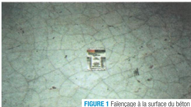
FIGURE 1 Faïençage à la surface du béton
