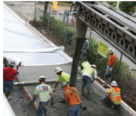
FIGURE 7 Mise en place du béton drainant
