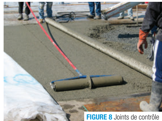
FIGURE 7 Mise en place du béton drainant
