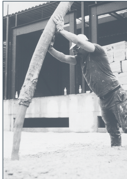
Figure 6-1 Pompage du béton
