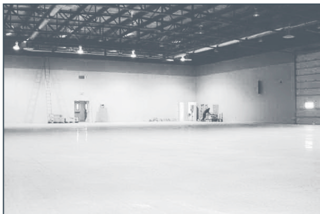
Figure 8-1 Dalles sans joints de contrôle
