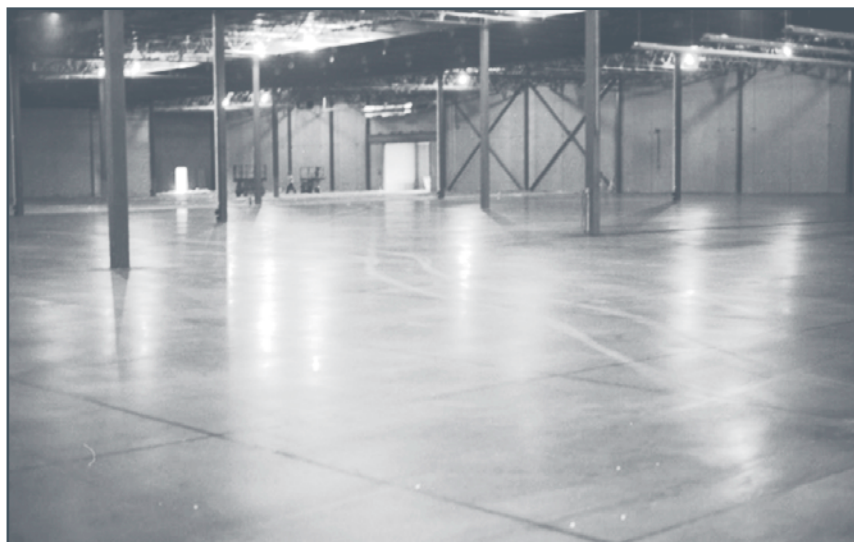
Figure 6-4 Traits de scie pour une dalle sur sol
