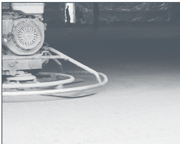
Figure 6-3 Finition du béton fibré
